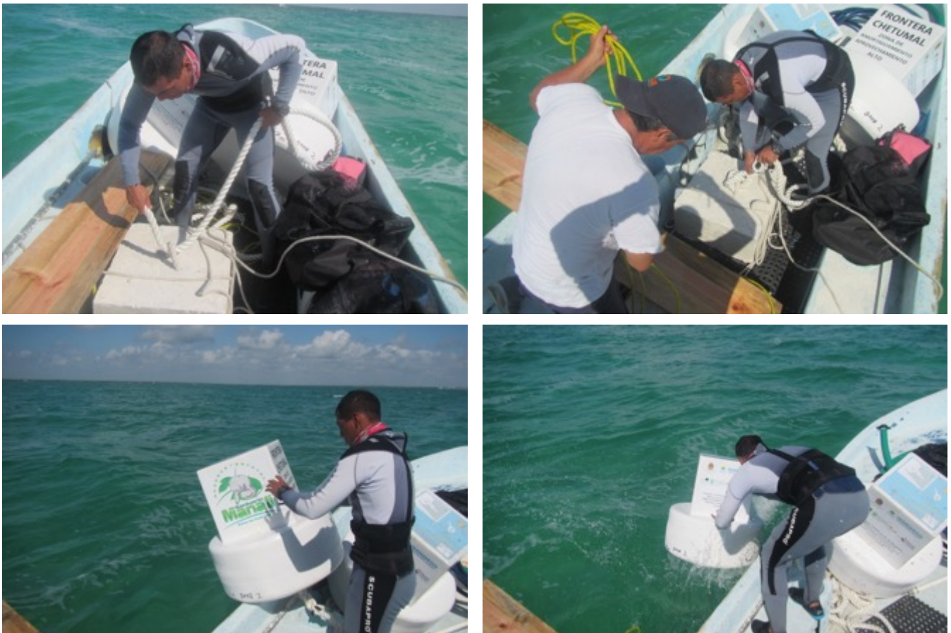
Figura 7. Instalación de Boyas en la zona marina.
